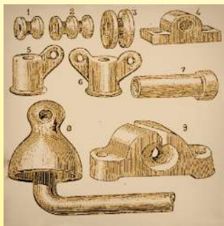
1885年高频瓷绝缘子 (La physique moderne: l'électricité dans la maison, É. Hospitalier)
